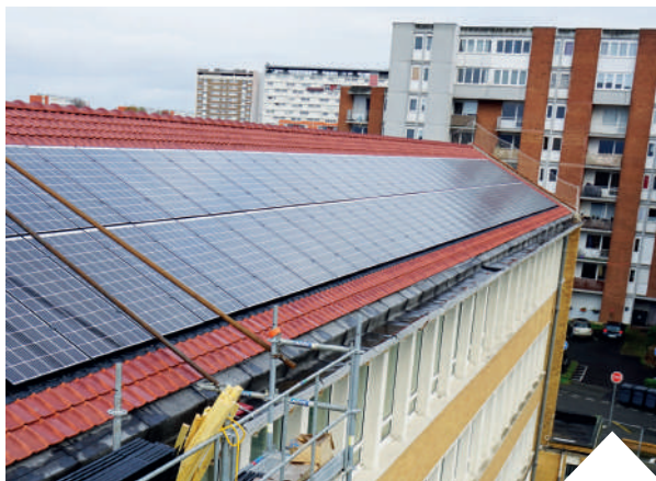
L'énergie produite par les panneaux photovoltaïques installés sur la toiture de l'école Victor Hugo est consommée sur place.
